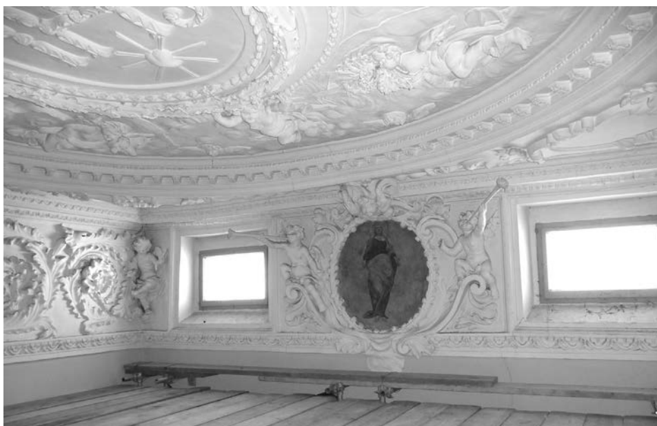
Il soffitto dello scalone durante i lavori di restauro.
